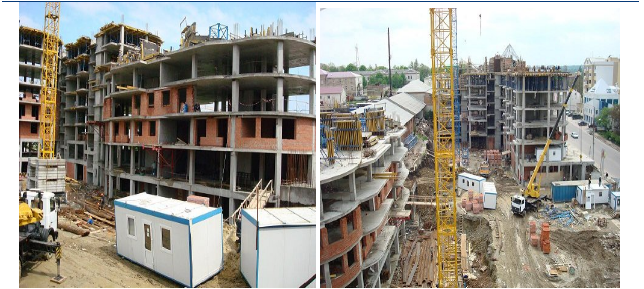
Хід будівництва групи багатоквартирних житлових будинків по вул. Червоноармійській, 43в у м. Чернівцях станом на 10.06.2008 р.
