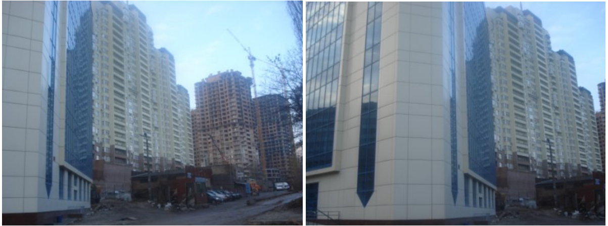
Житловий комплекс по вул. Механізаторів, 2 (ж/к «Времена года») у Солом'янському районі м. Києва
