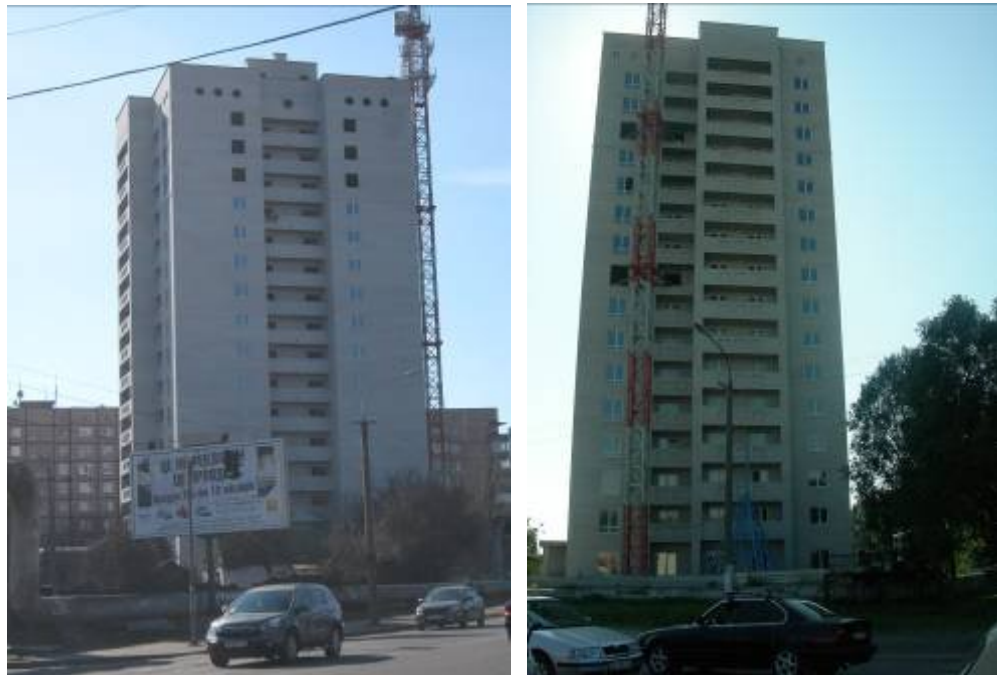
Рисунок 1.1. Ступінь будівельної готовності об'єкта в районі вулиць Космічної та Мадриківської, м. Дніпропетровськ (друга черга) станом: (зліва-направо): на кінець лютого 2009 року та на кінець травня 2009 року
