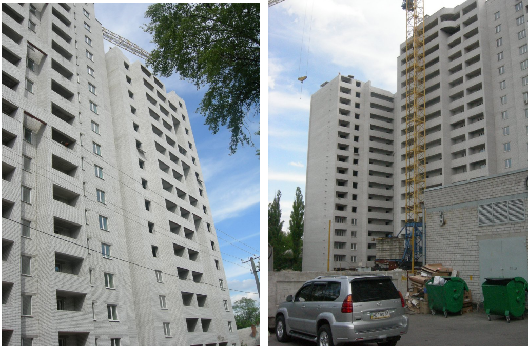
Рисунок 1.5. Об'єкт по вул. Дмитра Кедріна, в районі будинку №55, м. Дніпропетровськ станом на кінець травня 2009 року
