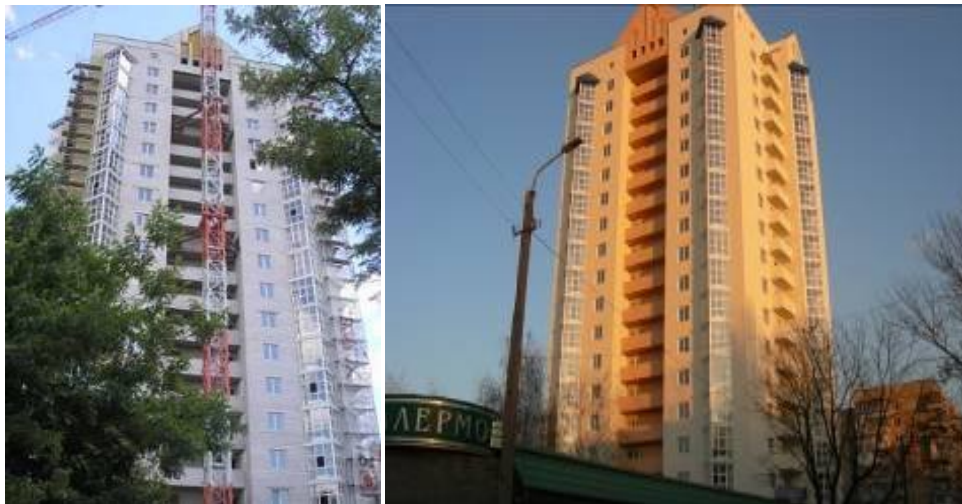
Рисунок 1.2. Об'єкт по проспекту газети «Правда» в районі будинку №16, м. Дніпропетровськ станом на 23.06.2008 р. та станом на кінець листопада 2008 року
