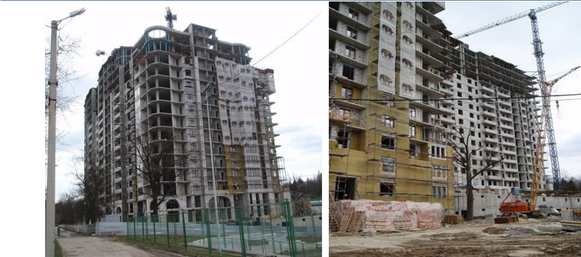
Стан будівництва житлового комплексу по вул. Фронтівій, 3 у м. Харкові станом на кінець квітня 2011 року
