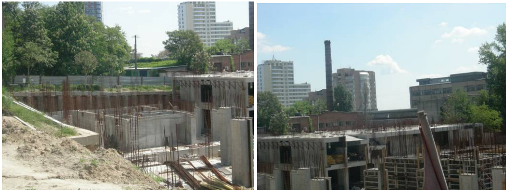
Рисунок 2. Будівництво житлового будинку по вул. Фурманова, 11 у м. Дніпропетровськ станом на кінець травня 2009 року
