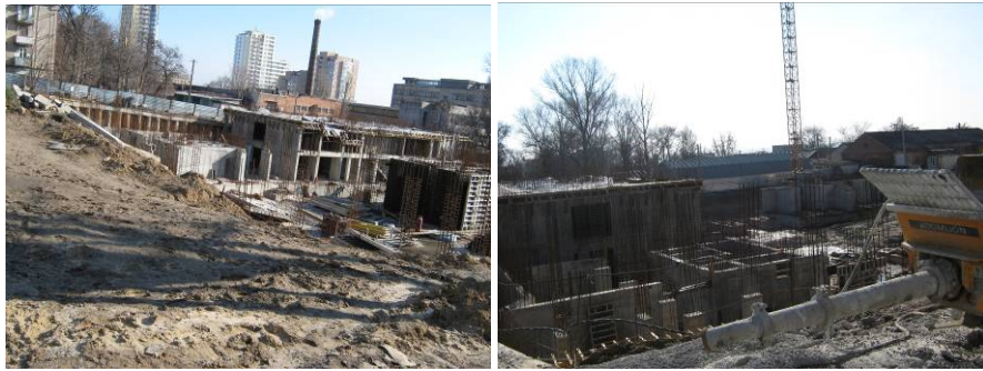
Рисунок 1. Будівництво житлового будинку по вул. Фурманова, 11 у м. Дніпропетровськ станом на середину лютого 2009 року
