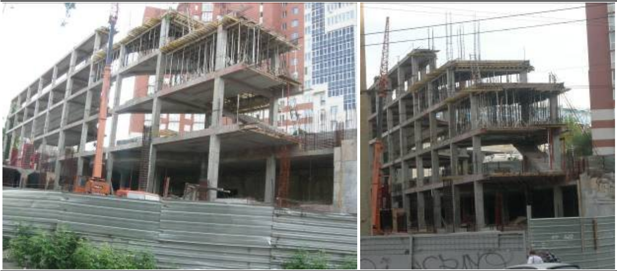
Стан реалізації інвестиційно-будівельного проекту у кварталі, що обмежений пр. Пушкіна – пров. Ушинського – вул. Щорса – вул. Херсонською, м. Дніпропетровськ, станом на кінець травня 2009 р.
