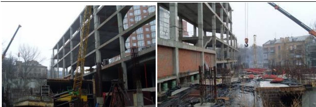
Стан реалізації інвестиційно-будівельного проекту у кварталі, що обмежений пр. Пушкіна – пров. Ушинського – вул. Щорса – вул. Херсонською, м. Дніпропетровськ, станом на початок лютого 2009 р.
