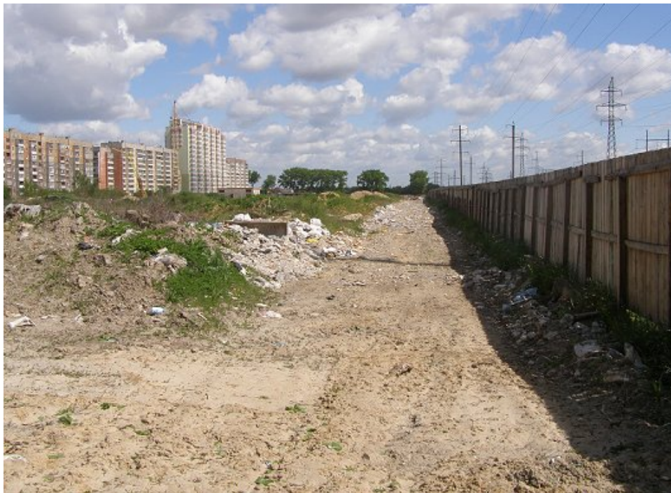
Хід робіт на об'єкті будівництва (II черга забудови кварталу Олімпійський) у м. Броварах Київської обл. станом на 14.05.2009 р.
