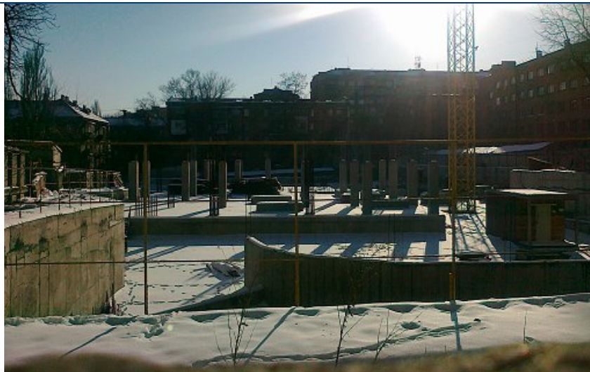
Хід робіт з будівництва багатопверхового житлового будинку з вбудовано-прибудованими приміщеннями громадського призначення та підземного паркінгу по вул. Білоруській, 36-а у Шевченківському районі м. Києва станом на 01.03.2011 р.
