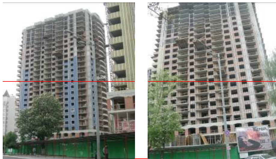
Рисунок 1.4. Хід будівництва житлового комплексу «Парк Авеню» (I черга) станом на 20.05.2009 р. (зліва-направо): будинок № 1 та будинок № 2
