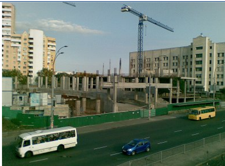
Стан будівництва офісної будівлі за адресою: м. Київ, пров. Індустріальний ,1-А на 14.11.2009 р.
