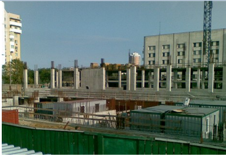
Стан будівництва офісної будівлі за адресою: м. Київ, пров. Індустріальний ,1-А на 29.08.2009 р.
