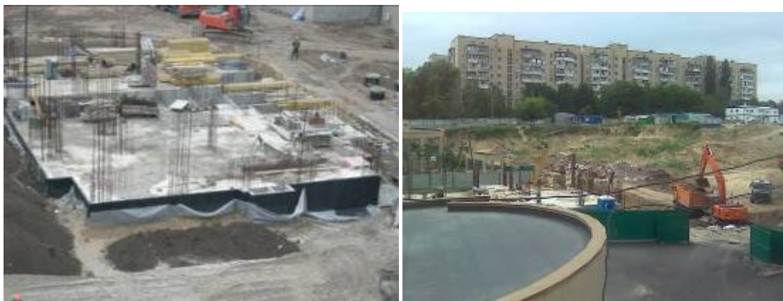
Хід будівництва житлового комплексу «Парк Авеню» (II- IX черги) станом (зліва - направо) на 03.12.2009 р. та станом на кінець червня 2010 р.
