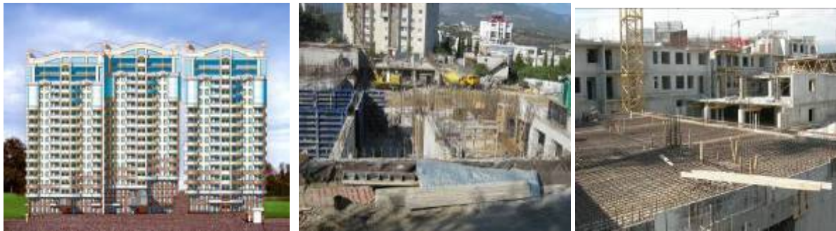
Макет житлового комплексу, який складається з житлових будинків (блок «Б1», блок «Б2», блок «Г») та підземних автостоянок (блок «А», блок «В») по вул. Жовтневій в районі житлового будинку №32 у м. Алушті та стан будівництва на початок лютого 2008 року та на 04.09.2008 р
