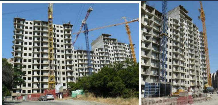
Стан будівництва житлового комплексу, який складається з житлових будинків (блок «Б1», блок «Б2», блок «Г») та підземних автостоянок (блок «А», блок «В») по вул. Жовтневій в районі житлового будинку №32 у м. Алушті станом на середину липня 2011 року.
