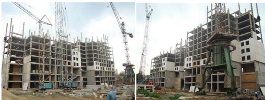
Будівельні роботи на об'єкті будівництва «Нова Перемога» у м. Дніпропетровську станом на кінець липня 2009 року
