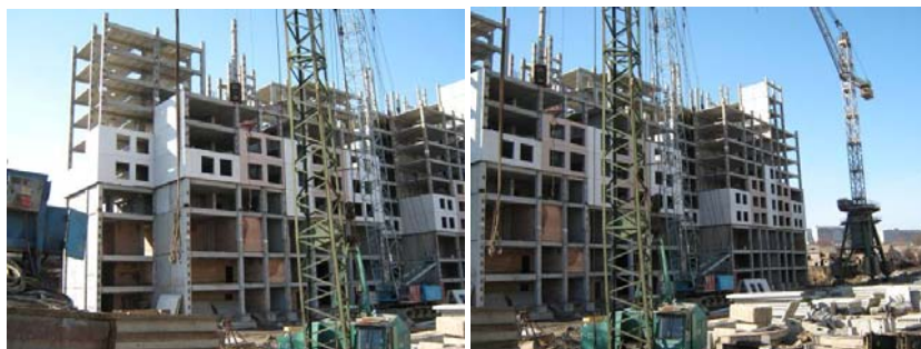
Будівельні роботи на об'єкті будівництва «Нова Перемога» у м. Дніпропетровську станом на 20.02.2009 р.
