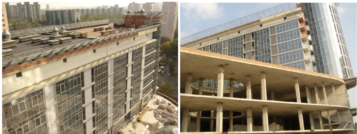
Рисунок 2. Будівельні роботи на об'єкті «Артеміда» за адресою м. Київ, перехрестя Дарницького бульвару та вул. Генерала Жмаченка станом на 24.09.2009 р.
