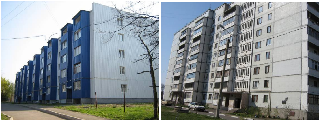
Реконструйований гуртожиток по вул. 17 Партз'їзду, 24 та житловий будинок по вул. Зубарева, 32 у м. Харкові (зліва-направо)
