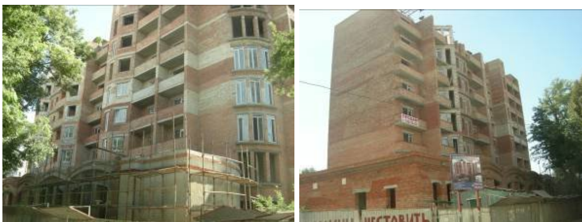
Будівництво житлового будинку по пров. Черепанових, 12. станом на серпень 2010 р.
