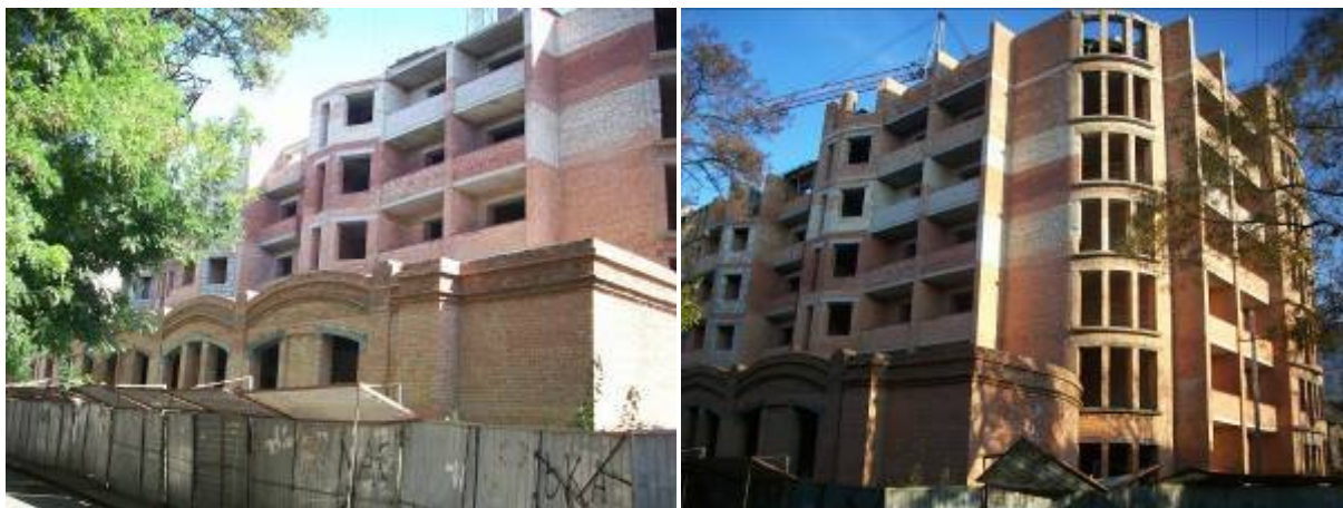
Будівництво житлового будинку по пров. Черепанових, 12. станом на 08.09.2009 р. та станом на 26.11.2009 р.
