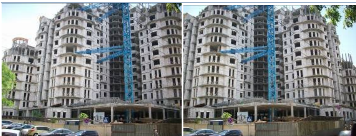
Рисунок 1.3. Будівельні роботи на об'єкті будівництва офісно-житлового комплексу по вул. Канатній, 27 станом на кінець травня 2009 р.
