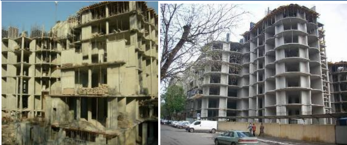
Рисунок 1.1. Будівельні роботи на об'єкті будівництва офісно-житлового комплексу по вул. Канатній, 27 станом на (зліва-направо) 29.02.2008 р. та кінець квітня 2008 р.
