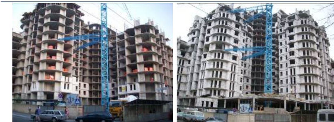
Рисунок 1.2. Будівельні роботи на об'єкті будівництва офісно-житлового комплексу по вул. Канатній, 27 станом на 22.08.2008 р. та на середину лютого 2009 р.
