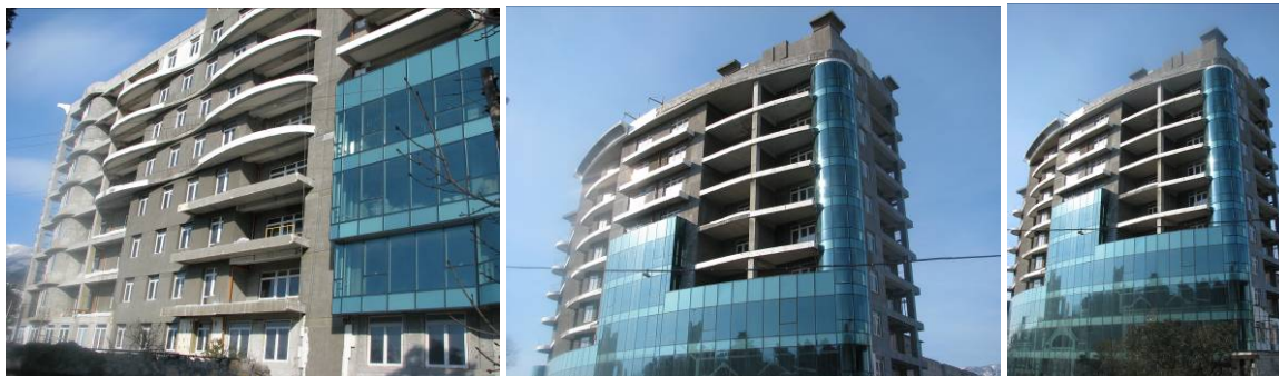
Рисунок Ошибка! Текст указанного стиля в документе отсутствует..1. Хід робіт на об'єкті будівництва житлового комплексу «Адміралтейський» класу «люкс» по вул. Руданського, буд. 8 Б станом на 20.02.2009 р.
