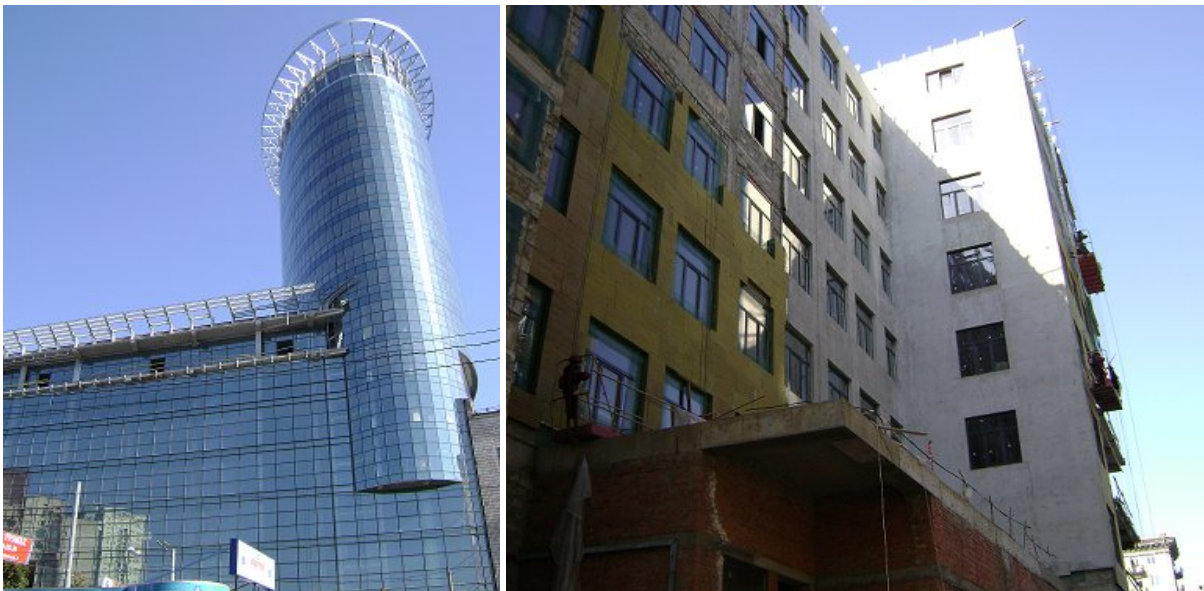
Хід робіт на об'єкті будівництва по вул. Мельникова, 2/10, станом на 22.09.2009 р.
