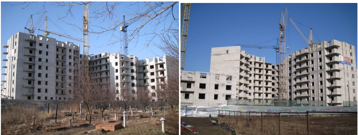
Хід робіт на об'єкті будівництва по пр. Тракторобудівників, в районі буд. 103 А у м. Харкові станом на 20.02.2009 р.
