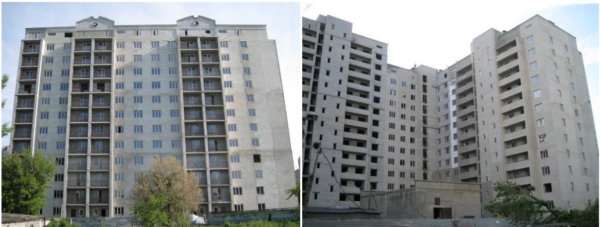
Будівництво житлового будинку по пр. Маршала Жукова-ріг Садового проїзду у м. Харкові
