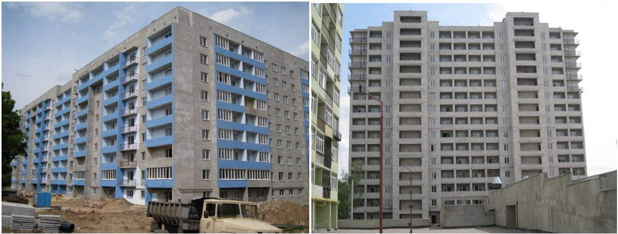
Житлові будинки по пр. Перемоги, 66-Д (буд. №1 та буд.№5) у м. Харкові
