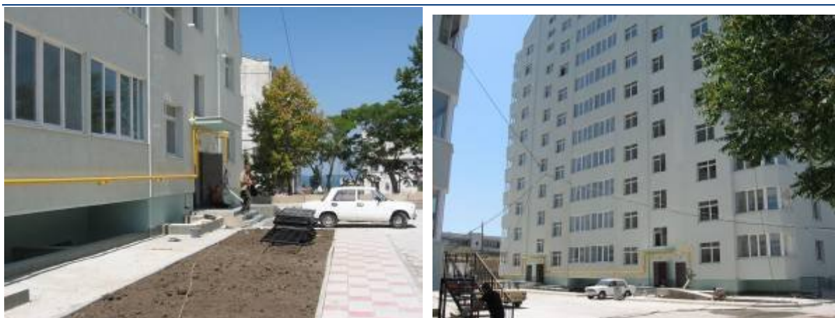
Стан будівництва 2-х житлових будинків по вул. Рєпіна, 19 у м. Севастополі станом на кінець липня 2009 р.
