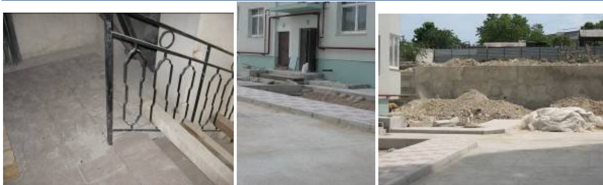
Стан будівництва 2-х житлових будинків по вул. Рєпіна, 19 у м. Севастополі станом на червень 2009 р.
