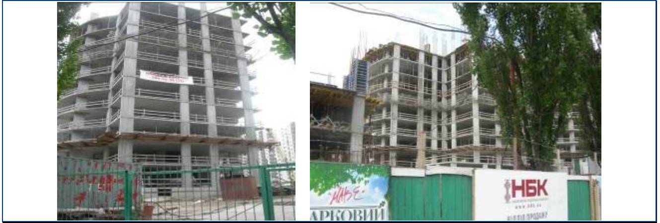
Будівельні роботи на секціях 1-3 житлового будинку № 26 станом на середину травня 2009 року
