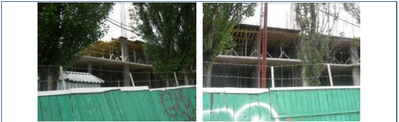
Будівельні роботи на секціях 1-4 житлового будинку № 28 станом на середину травня 2009 року
