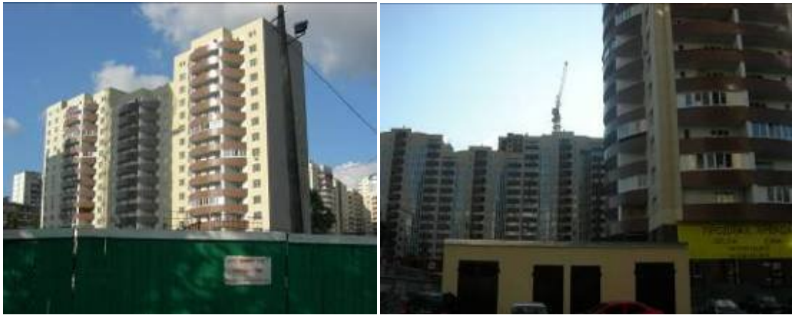
Секції 5-11 житлового будинку № 28
