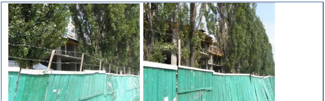
Будівельні роботи на секціях 1-4 житлового будинку № 28 станом на кінець серпня 2009 року
