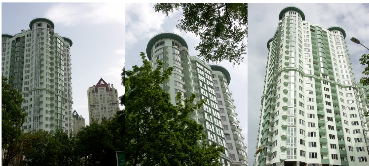
Рисунок 1.1. Житловий комплекс по вул. Механізаторів, 2 (ж/к «Ізумрудний») у Солом'янському районі м. Києва
