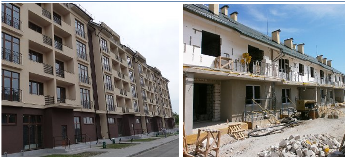
Житловий комплекс «Бородіно» по вул. Медичній у м. Запоріжжі станом на 15.05.2012 р. (зліва на право: житловий будинок №2, житловий будинок №6)
