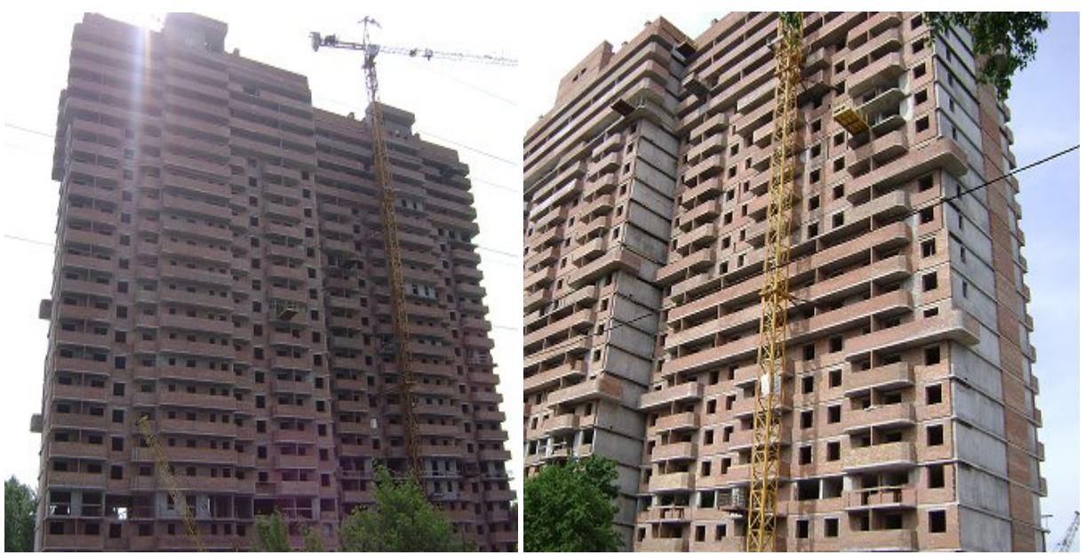
Будівельні роботи на об'єкті будівництва в м. Києві по вул. Генерала Наумова, 66 станом на 05.05.2009 р.
