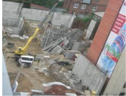
Будівництво багатофункціонального комплексу по вул. Шевченка, 53, станом на 21.09.2007 р.
