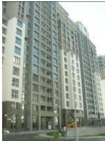
Ж/б 2 по вул. Професора Підвисоцького у Печерському районі м. Києва
