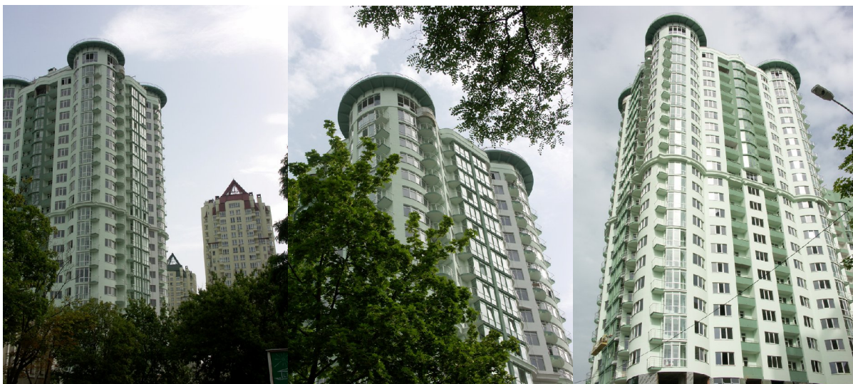
Рисунок 1. Будівельні роботи на об'єкті будівництва Житловогой комплекс у по вул. Механізаторів, 2 (ж/к «Ізумрудний») у Солом'янському районі м. Києва
