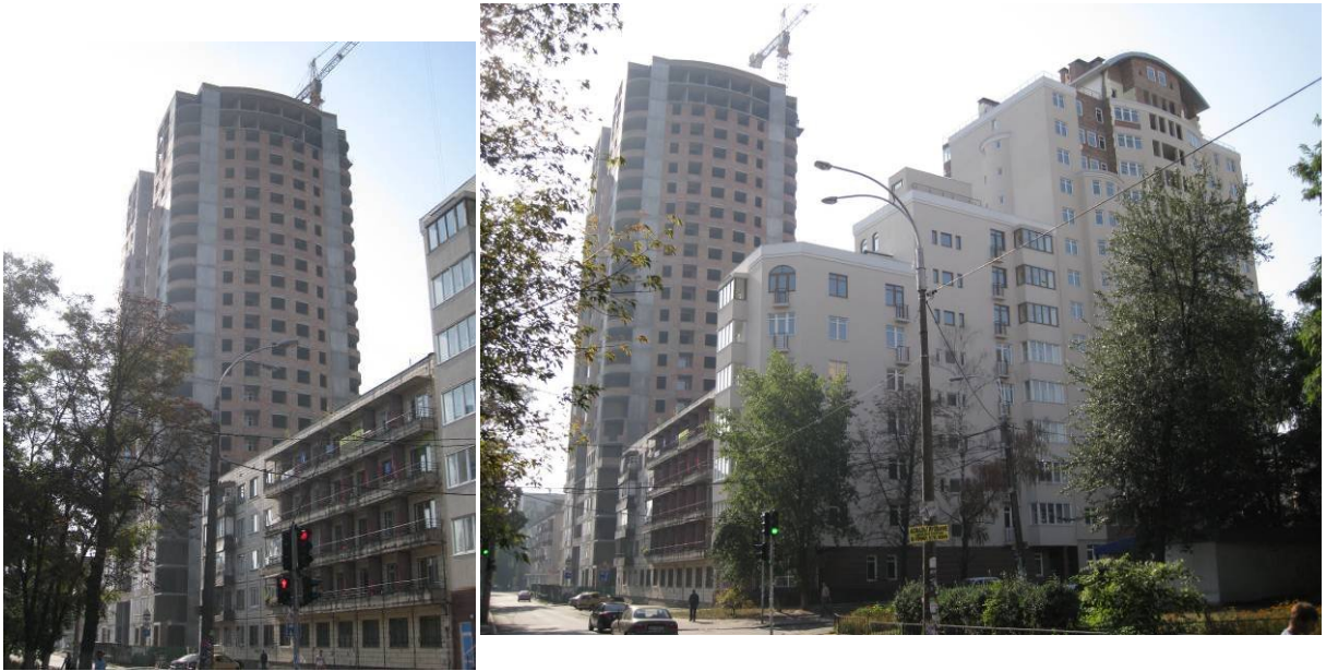
Стан будівництва житлових будинків №№ 1, 2, 4 по вул. М. Кривоноса та Климента на 16.09.2009 р.
