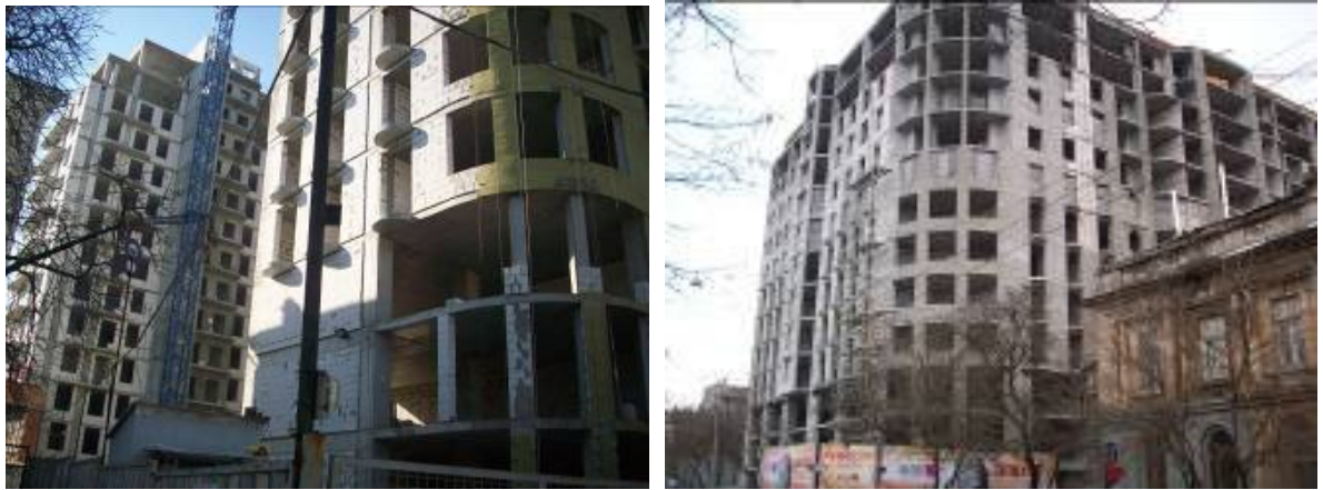
Рисунок Ошибка! Текст указанного стиля в документе отсутствует..3. Хід будівництва житлово-торговельного комплексу по вул. Грецькій, 1 у м. Одесі станом на кінець жовтня 2008 р. та станом 20.02.2009 р.
