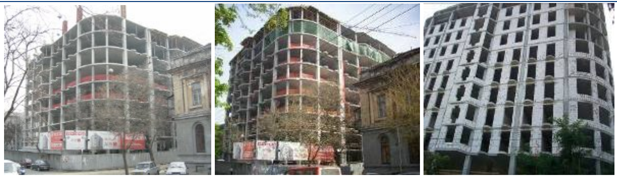
Рисунок Ошибка! Текст указанного стиля в документе отсутствует..2. Хід будівництва житлово-торговельного комплексу по вул. Грецькій, 1 у м. Одесі станом (зліва-направо) на 01.03.2008 р., на початок травня 2008 р. та на 22.08.2008 р.
