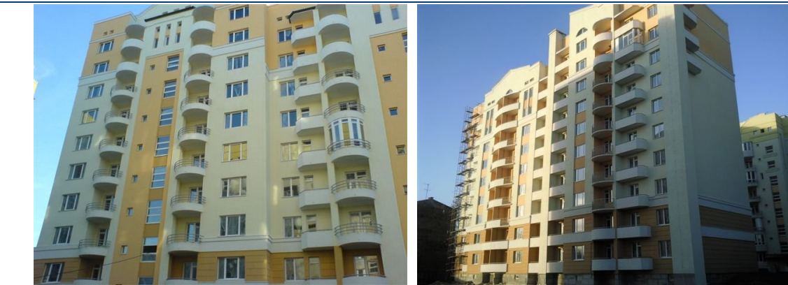
Хід робіт на об'єкті будівництва по вул. Юнаківа, 9 (буд. №№ 2, 3) у м. Львові станом на 02.12.2008 р.
