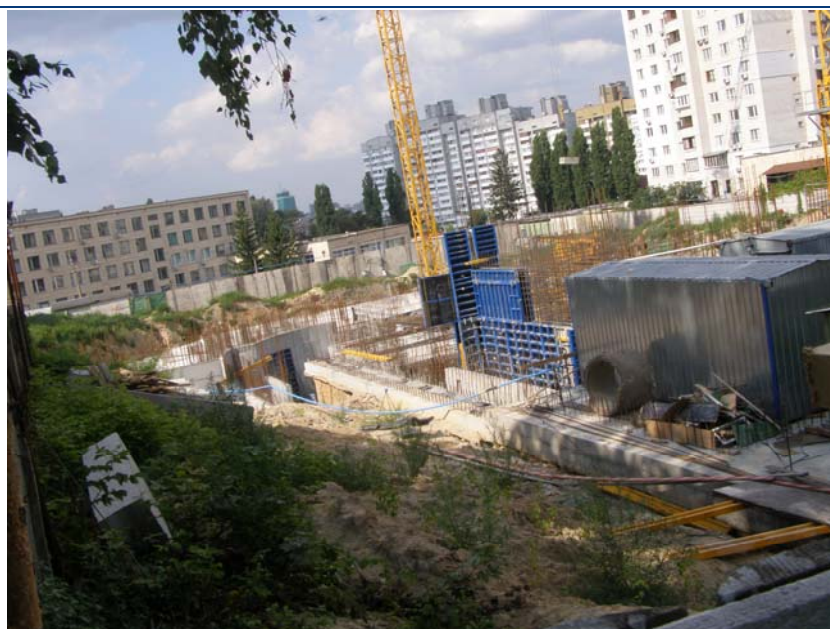
Хід робіт на об'єкті будівництва житлово-офісного комплексу з вбудовано-прибудованими торговельними приміщеннями, закладами громадського харчування та підземною автостоянкою по вул. М. Островського, 40 у м. Києві станом на середину серпня 2011 року
