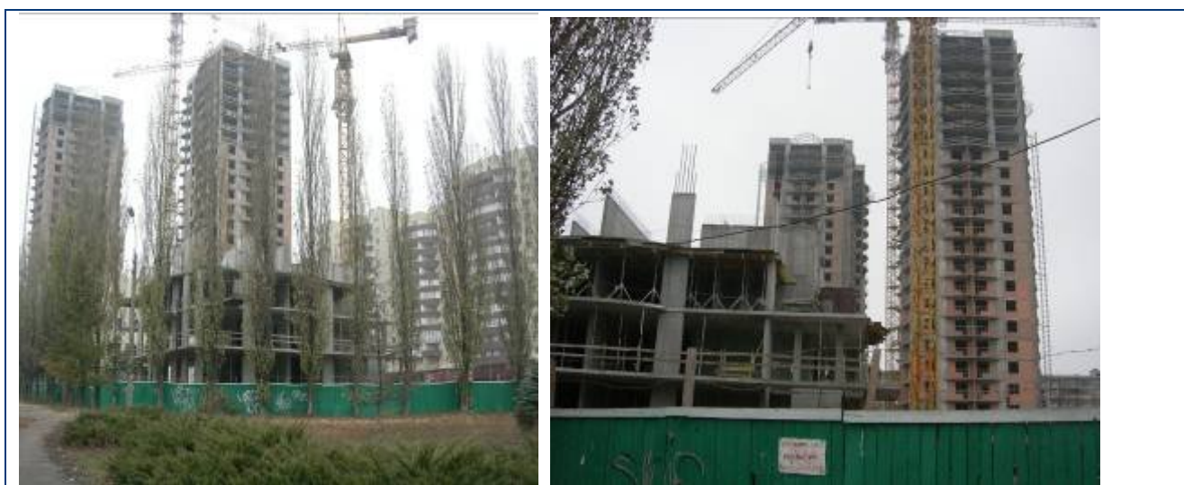
Будівельні роботи по житловим будинкам №№ 33 та 34 та № 35 станом на початок листопада 2009 року
