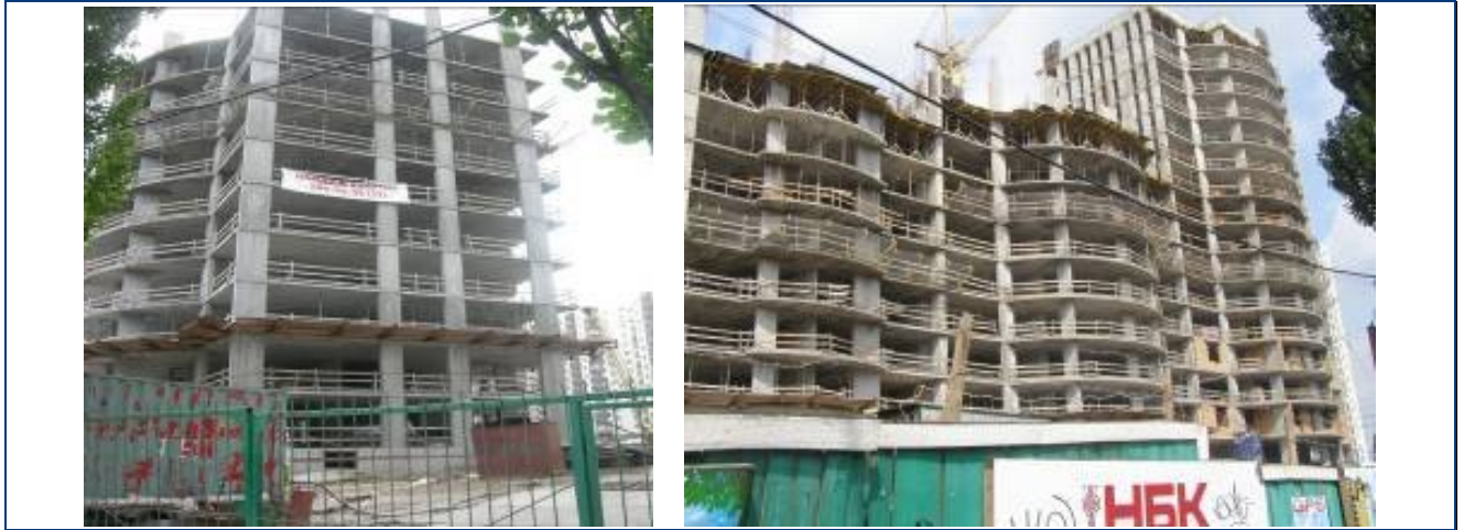
Будівельні роботи на секціях 1-3 житлового будинку № 26 станом на середину травня 2009 року
