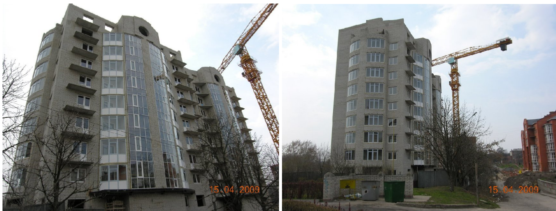
Рисунок 1.3. Хід робіт на об'єкті будівництва по вул. Новомістенській, 1/2 у м. Сумах станом на 15.04.2009 р.
