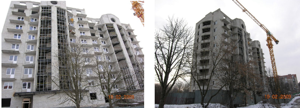
Рисунок 1.2. Хід робіт на об'єкті будівництва по вул. Новомістенській, 1/2 у м. Сумах станом на 19.02.2009 р.
