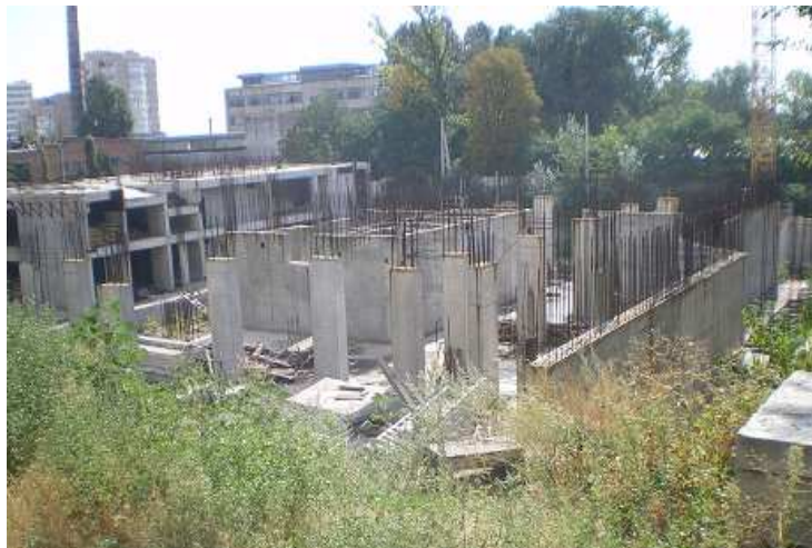
Об'єкт незавершеного будівництва по вул. Фурманова, 11 у м. Дніпропетровську, станом на початок серпня 2012 року
