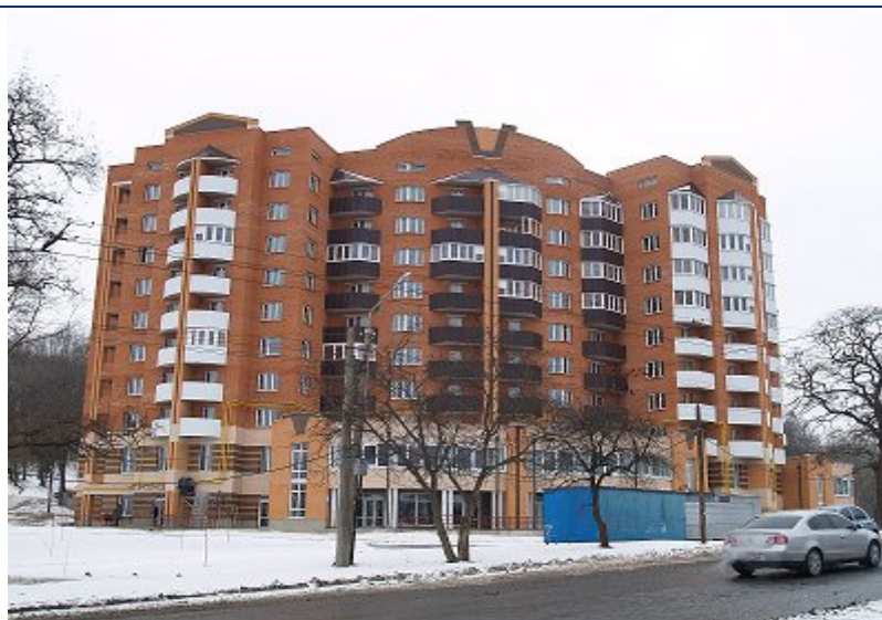
Житловий будинок по вул. Леніна, 74 у м. Полтаві, станом на 25.02.2011 р.
