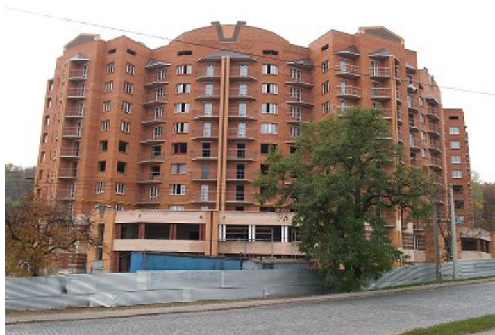
Житловий будинок по вул. Леніна, 74 у м. Полтаві, станом на 26.10.2010 р.
