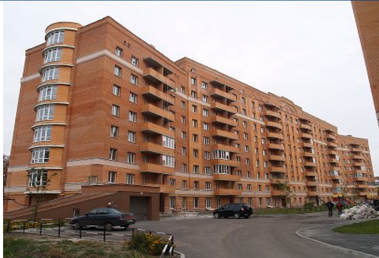
Житловий будинок по вул. Жовтневій, 40-Д у м. Полтаві, станом на 26.10.2010 р.
