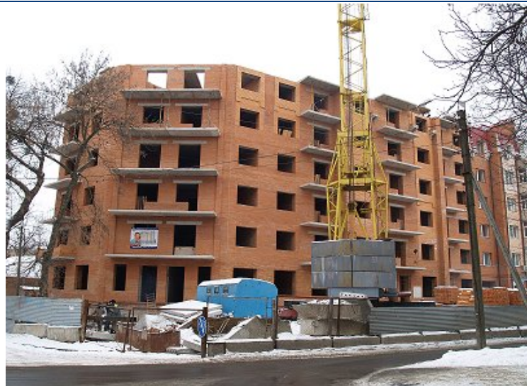
Житловий будинок по вул. Паризької комуни, 24 (II черга) у м. Полтаві, станом на 25.02.2011 р.
