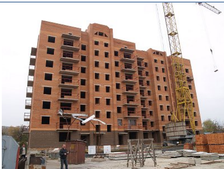
Житловий будинок по вул. Панянка, 65-67 у м. Полтаві, станом на 26.10.2010 р.
