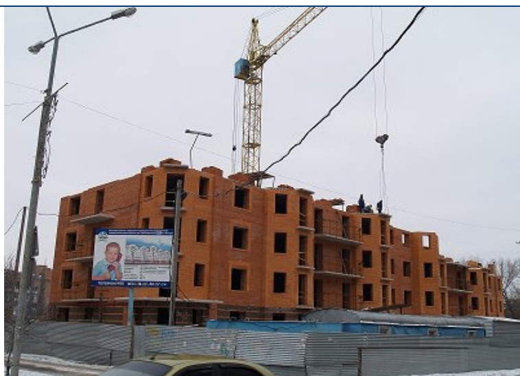
Житловий будинок по вул. Пролетарська, 27-29 у м. Полтаві, станом на 25.02.2011 р.
