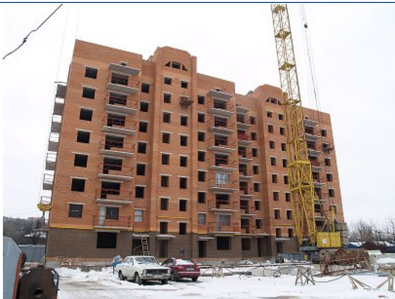
Житловий будинок по вул. Панянка, 65-67 у м. Полтаві, станом на 25.02.2011 р.
