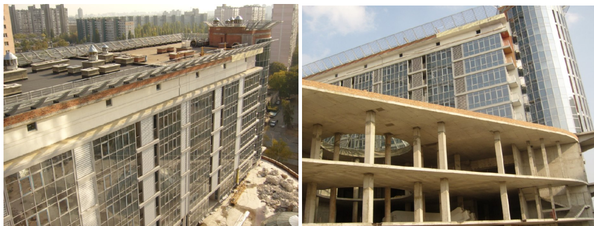
Рисунок 1. Будівельні роботи на об'єкті «Артеміда» за адресою м. Київ, перехрестя Дарницького бульвару та вул. Генерала Жмаченка станом на 24.09.2009 р.
