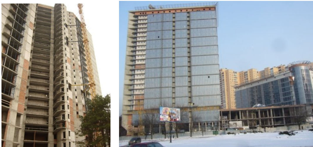
Рисунок 2. Будівельні роботи на об'єкті «Артеміда комплекс» за адресою м. Київ, перехрестя Дарницького бульвару та вул. Генерала Жмаченка станом на початок 2010 р.
