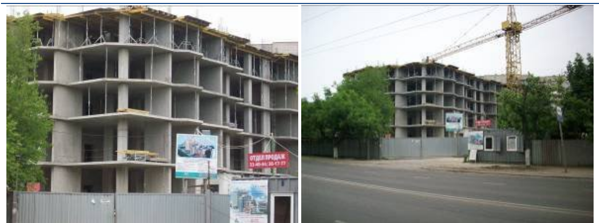
Рисунок Ошибка! Текст указанного стиля в документе отсутствует..4. Хід робіт на об'єкті будівництва по вул. Малиновського (в межах вул. Заводської та пров. Союзного) в м. Одесі станом на кінець травня 2009 р.
