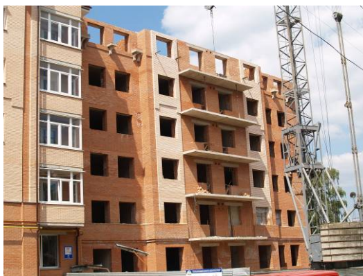
Житловий будинок по вул. Паризької комуні, 20 у м. Полтаві, станом на середину червня 2009 року
