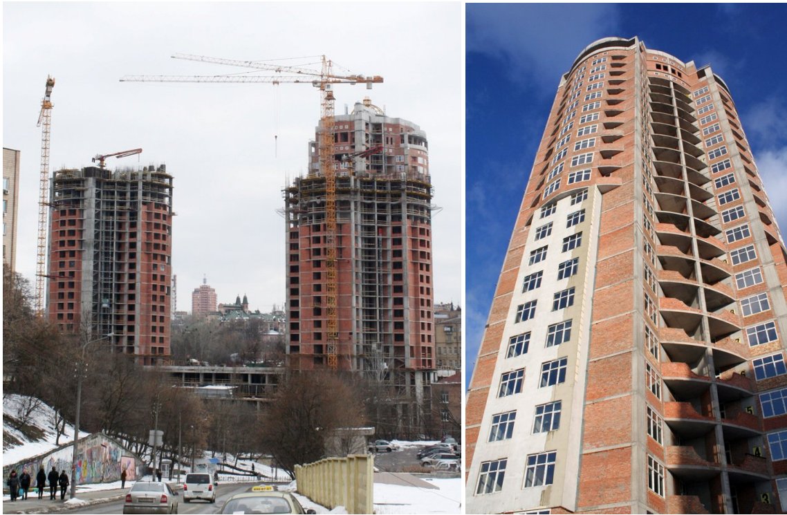
Будівельні роботи на об'єкті будівництва офісно-житлового комплексу в м. Києві на ділянці, обмеженої вулицями Глибочицькою, Студентською та Пимоненка станом на лютий 2012 року
