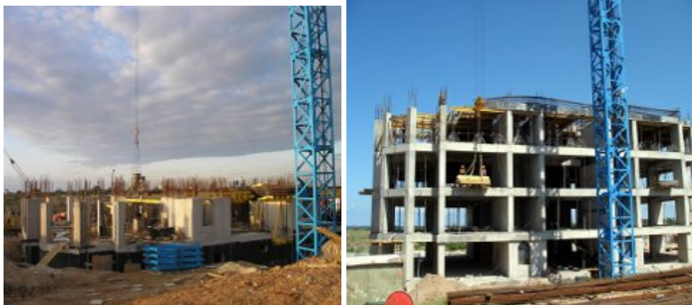
Стан виконання будівельних робіт по корпусу 6 в мікрорайоні «Омега-2а» у м. Севастополі станом на листопад 2007 року та на кінець травня 2008 року
