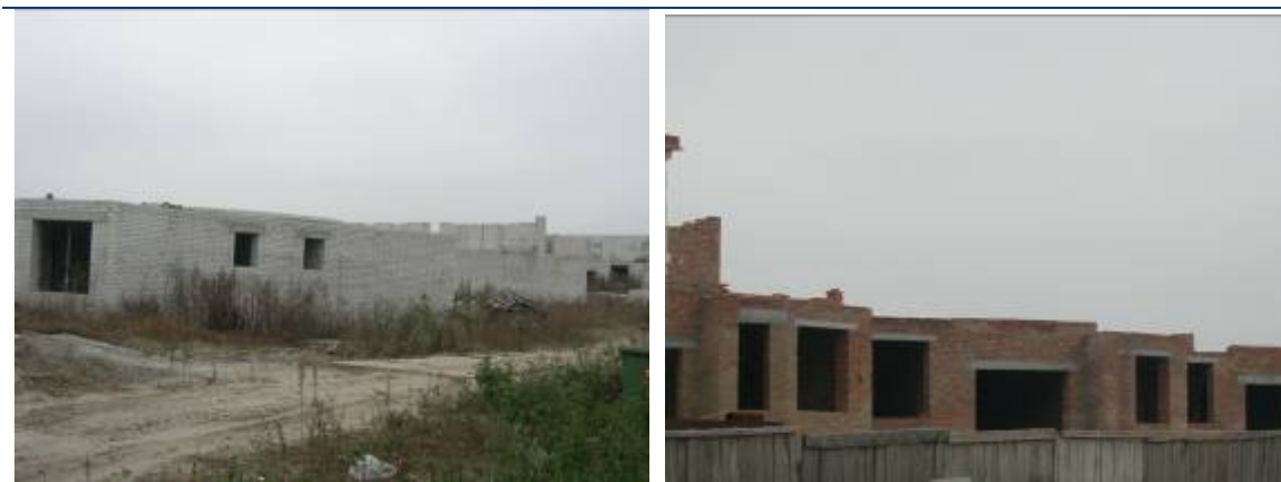
Хід будівництва житлового комплексу з об'єктами соціально-побутової інфраструктури по вул. Леніна, 119 у с. Петропавлівська Борщагівка Києво-Святошинського району Київської області станом на початок листопада 2009 року
