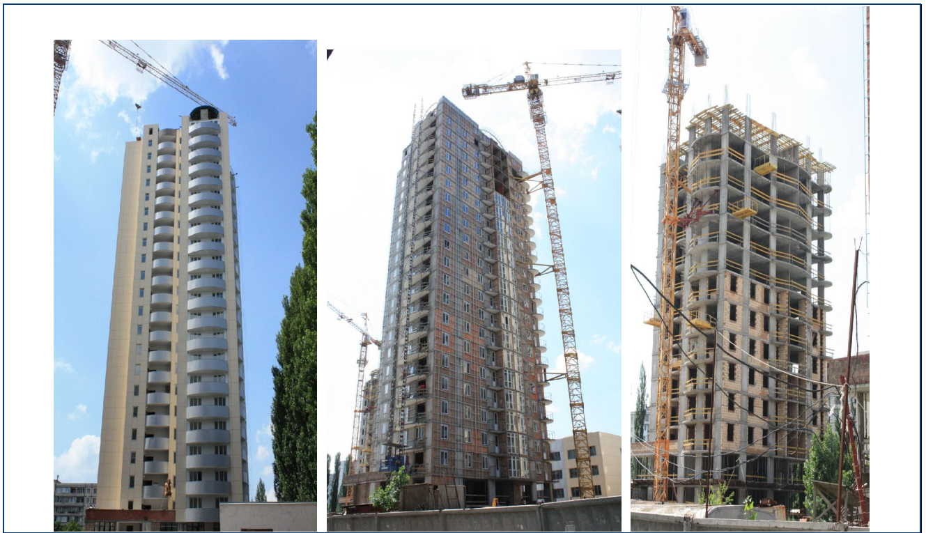
Рисунок 5. Будівельні роботи по житловим будинкам №№ 33 та 34 та № 35 станом на липень 2011 року
