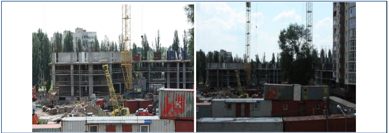
Рисунок 3. Будівельні роботи на секціях 1-4 житлового будинку № 28 станом на кінець липня 2011 року
