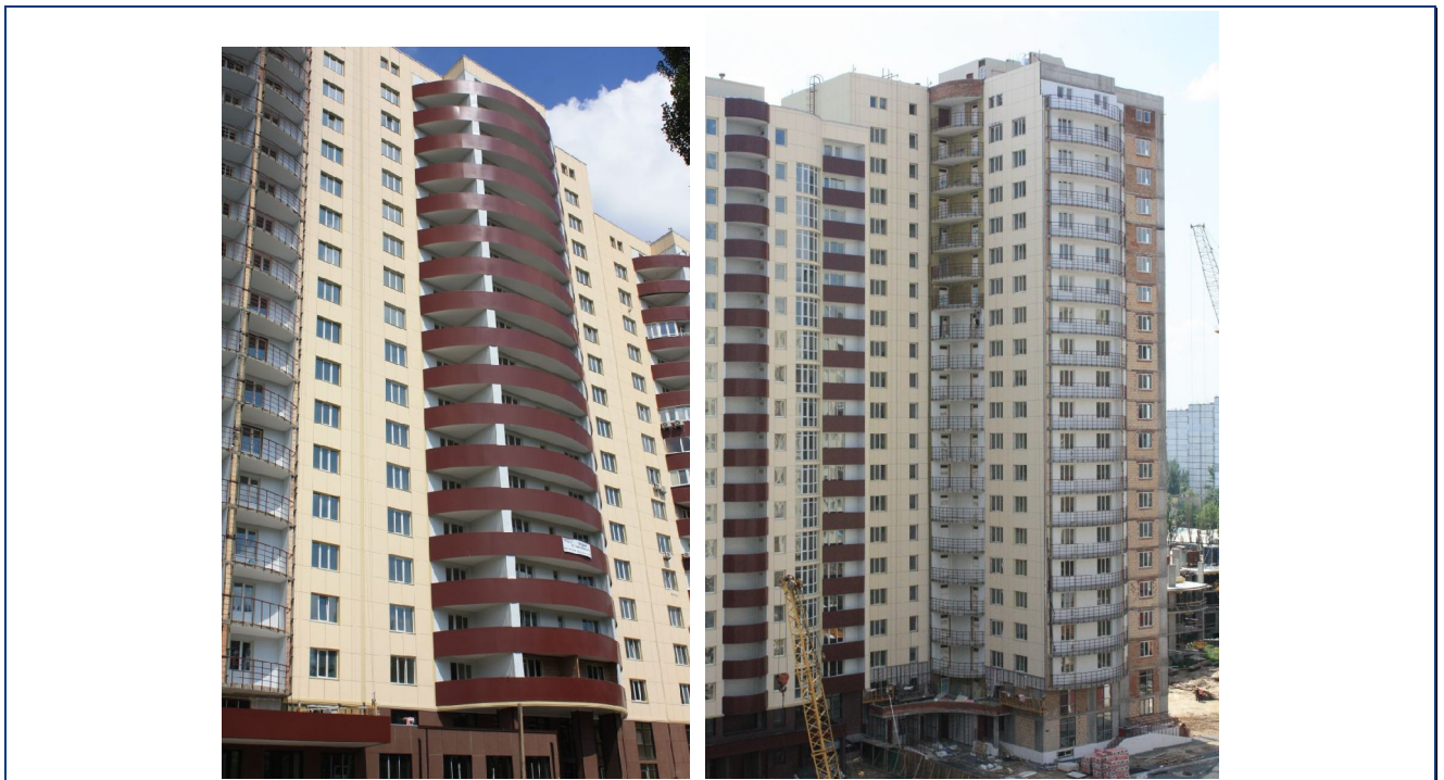
Рисунок 4. Будівельні роботи на секціях 2 та 3 житлового будинку № 26 станом на кінець липня 2011 року
