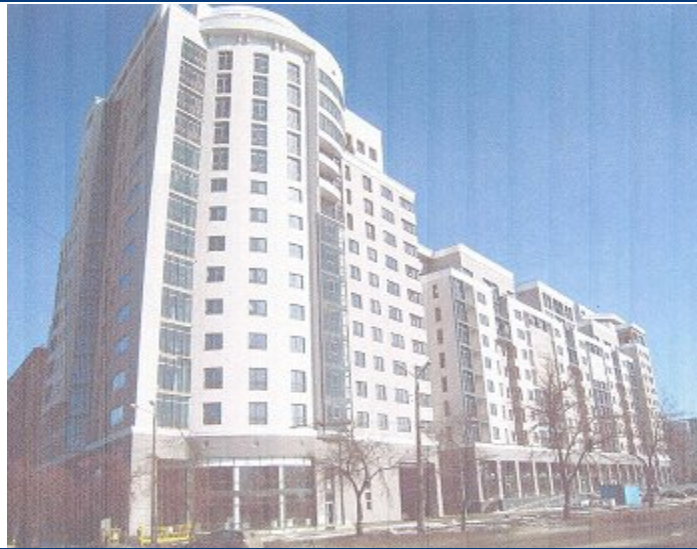
Об'єкт будівництва по пров. Банному в м. Харкові станом на початок 2010 року
