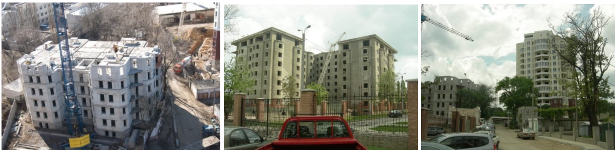
Рисунок Ошибка! Текст указанного стиля в документе отсутствует.. Стан будівництва по вул. Хантадзе, 7 Б у м. Іллічівську станом на березень та червень 2010 року
