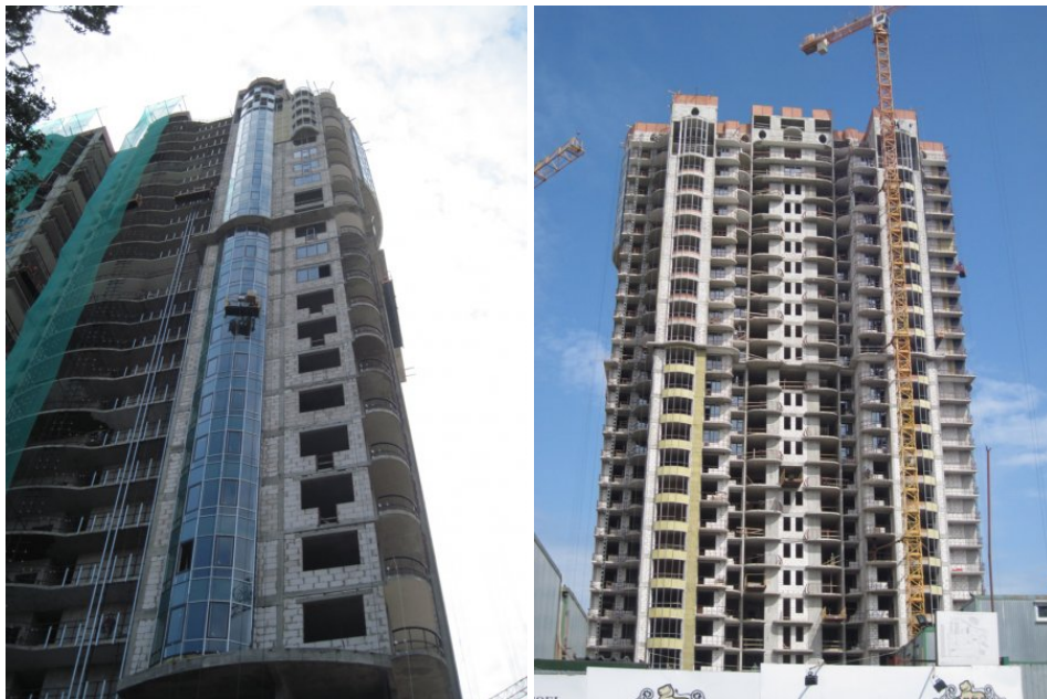
Рисунок 1.4. Будівництво житлово-офісного комплексу з вбудованими, прибудованими приміщеннями та підземним паркінгом по вул. Анрі Барбюса, 37/1 у Печерському районі м. Києва станом на середину травня 2011 року.
