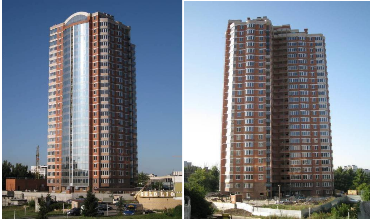
Житловий комплекс з підземним паркінгом по провулку Отакара Яроша у м. Харкові
