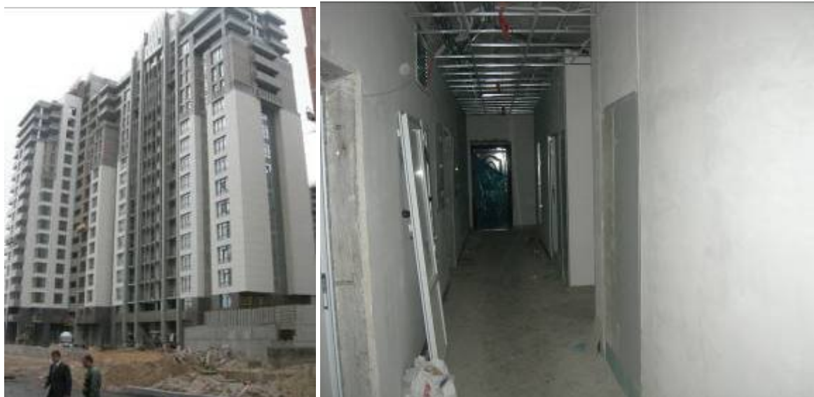
Хід робіт з будівництва ж/б 5 по вул. Професора Підвисоцького у Печерському районі м. Києва станом (зліва-направо): на 03.09.2009 р. та на 19.11.2009 р.
