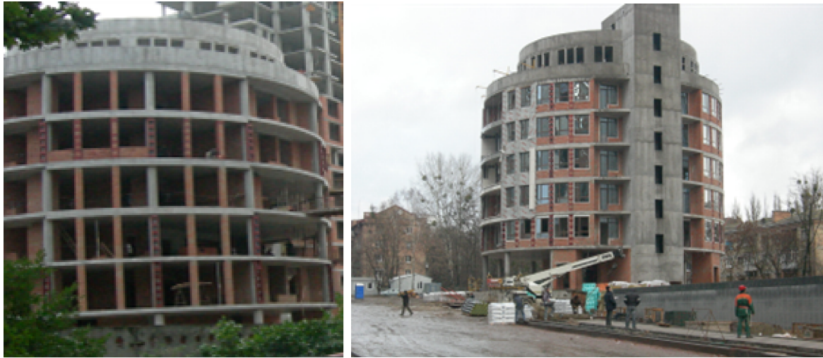
Хід робіт з будівництва ж/б 1 по вул. Професора Підвисоцького у Печерському районі м. Києва станом (зліва-направо): на 03.09.2009 р. та на 19.11.2009 р.
