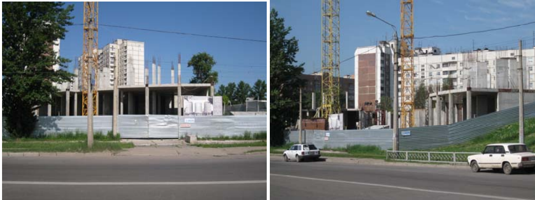
Будівництво ж/б з вбудовано-прибудованими приміщеннями культурно-побутового, адміністративного призначення та торговельного центру, з підземним паркінгом та гостьовою автостоянкою по вул. Шевченка (район вул. Саперної) у м. Харкові станом на кінець серпня 2009 року
