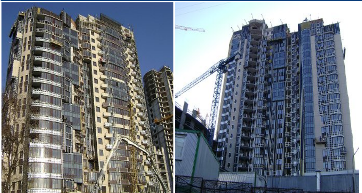
Будівництво житлово-офісного комплексу з вбудованими, прибудованими приміщеннями та підземним паркінгом по вул. Анрі Барбюса, 37/1 у Печерському районі м. Києва станом на 26.11.2010 р.
